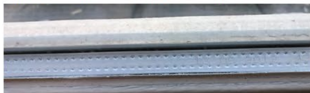
Isopane glas uit 2010, HR4*-10-5 met Argon U = 1.8 \text{ W/m}^2\text{K} .
