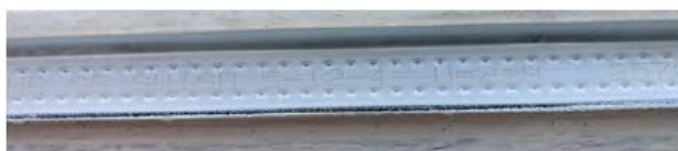
Sain Gobain glas uit 2012, 5-12-4 U = 2.8 \text{ W/m}^2\text{K} .
