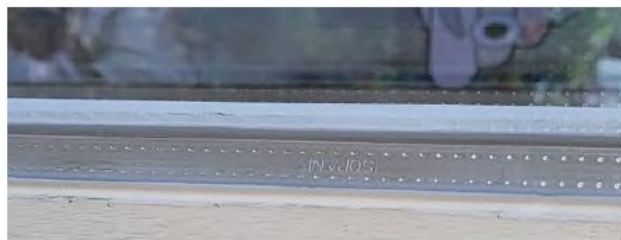
Isopane glas uit 2010, HR4*-10-5 met Argon U = 1.8 \text{ W/m}^2\text{K} .
