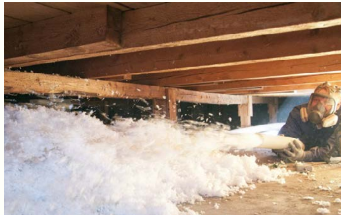
Isolatie souterrain Rc 5 (beganegrond vloer) en Rc 3,5 (wanden bergingen naar bewoond deel soutt.)
