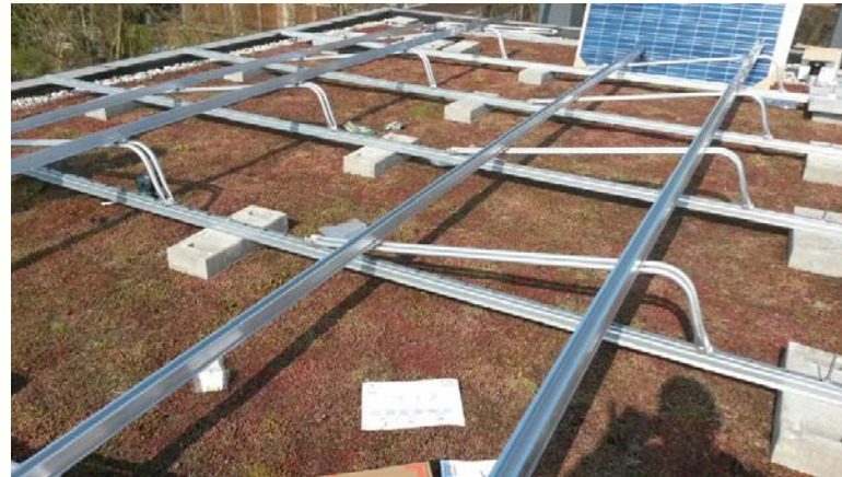
Zonnepanelen – onderconstructie (kan ook op sedum) en dakveiligheidssysteem
