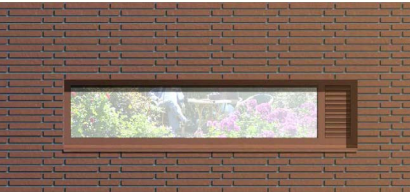
Raamkozijnen souterrain in kleur baksteen U=1,1 met verticaal ventilatierooster
