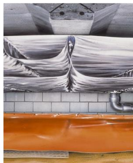
Vloerisolatie met aluminium isolatiefolie
