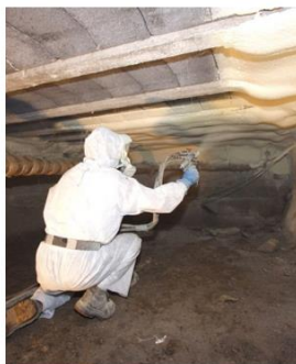
Vloerisolatie met PUR
