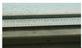
Afstandhouder in HR ++ -glas met merk/type glas en plaatsingsdatum
