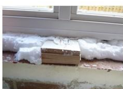
Luchtlekken tussen kozijn en gevels
