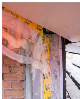
De hele buitengevel wordt vervangen door een prefab geïsoleerd element.
