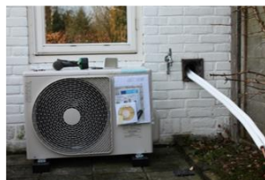
Een gat in de gevel voor de leidingen naar de buitenunit van de warmtepomp
