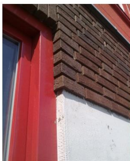
De gevel wordt van buitenaf geïsoleerd en afgewerkt met steenstrips.
