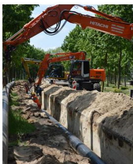
De leidingen voor het warmtenet worden in de straat gelegd
