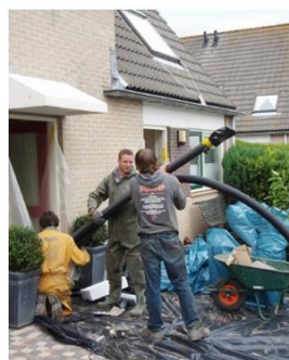
Ook in de voortuin zijn werkzaamheden nodig om de leidingen het huis in te brengen.
