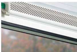
Roosters zorgen voor luchttoevoer. Hiervoor moet ook het glas worden vervangen
