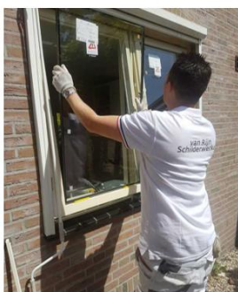
Glas plaatsen in bestaande kozijnen
