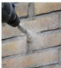
Spouwmuurisolatie wordt aangebracht via gaten in de gevel
