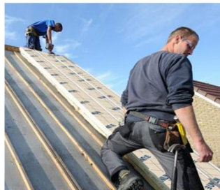
Het dak van buitenaf isoleren
