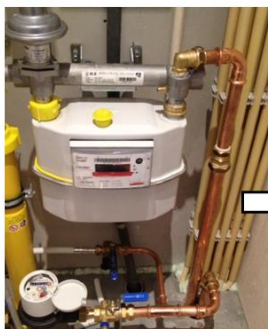
De gasmeter wordt verwijderd
