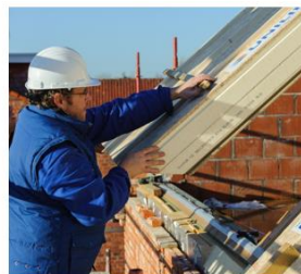
Plaatsen nieuwe dakelementen
