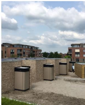
Warmtepomp als 'aanbouw'
