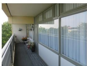
Doorgestorte constructies tussen binnen en buiten (uitkragende balkons links en loggia rechts)
