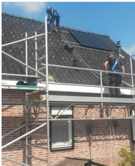
De PV-panelen worden op het dak gemonteerd
