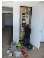
Extra fases in meterkast aanbrengen
