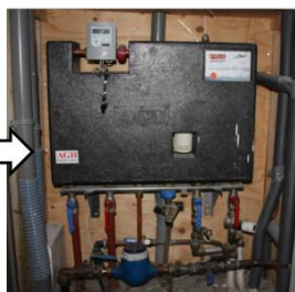
en vervangen door de afleverzet voor het warmtenet.
