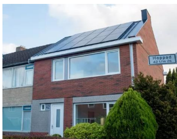
Gebouw – CO 2 reductie
